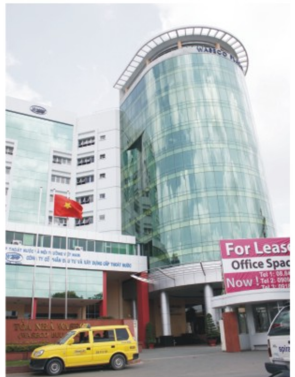
TÒA NHÀ WASECO
